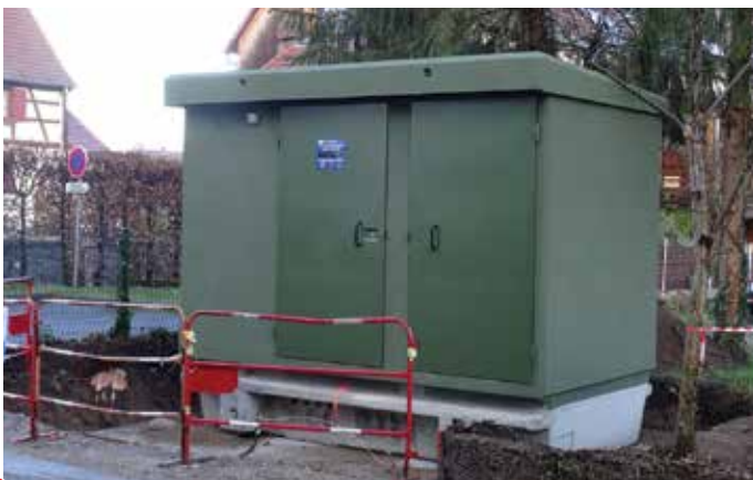
Le nouveau transformateur électrique
