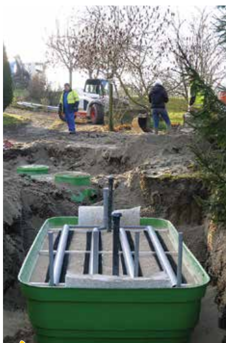
Installation d'un lit filtrant
