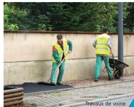
Travaux de voirie
