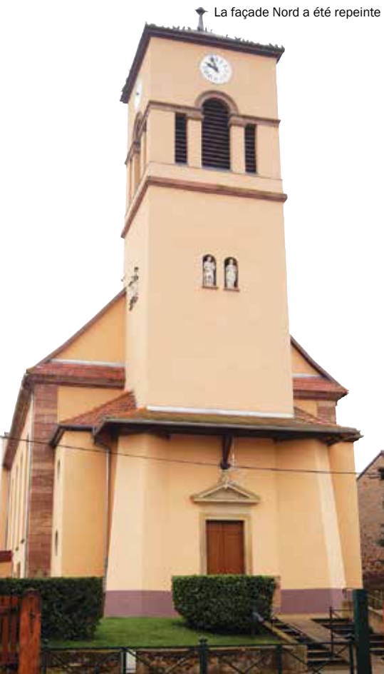
La façade Nord a été repeinte
